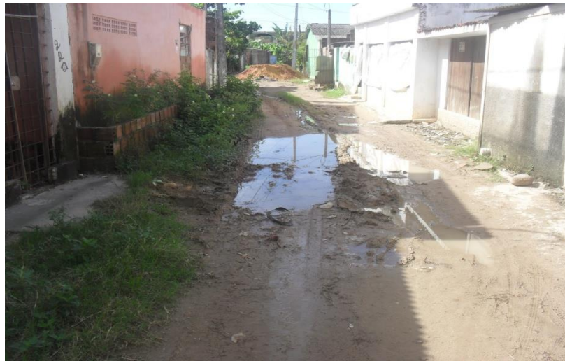
Comunidade Guabiraba - Itambé-PE /Monitora: Gilda Maria Tema Gerador: Ruas esburacadas
